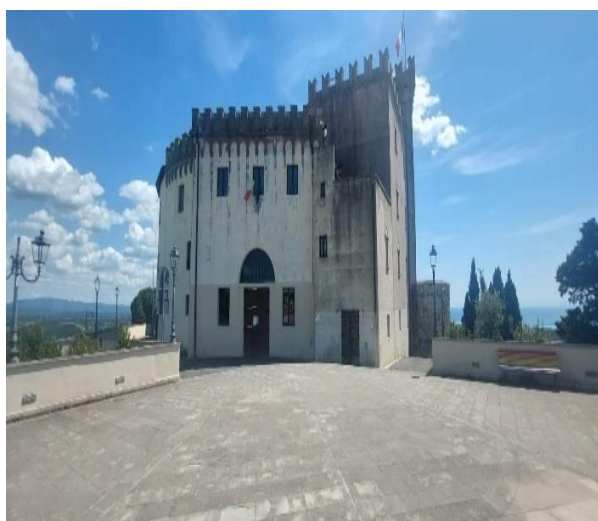
32 percorso dalla terrazza al castello
