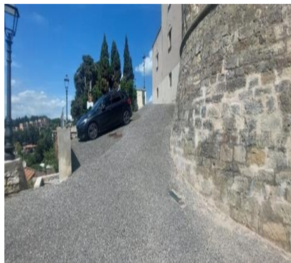
35 rampa di discesa per ingresso al castello
