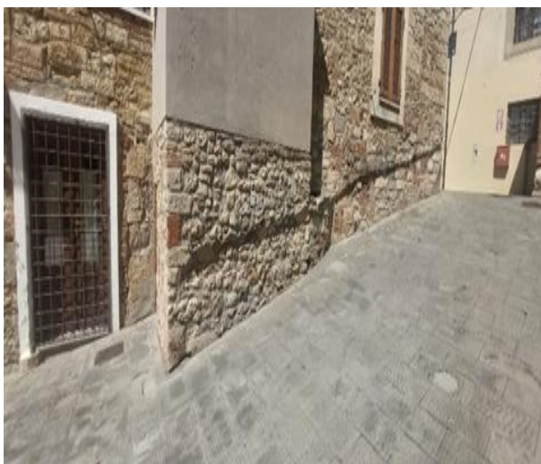
44 corrimano sul lato sinistro del castello
